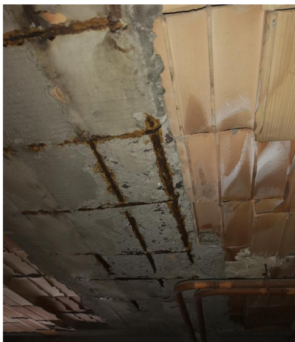
Figura 17 – Ossidazione armatura trave Corpo E – piano interrato
