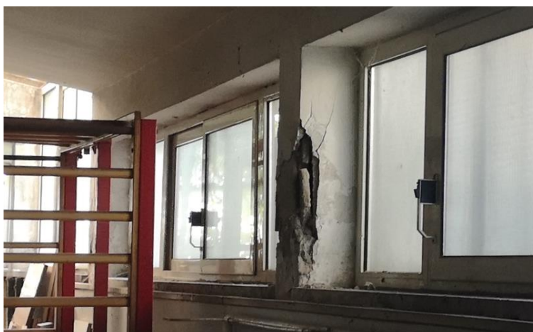
Figura 18 – Ossidazione armatura pilastri Corpo D – piano interrato
